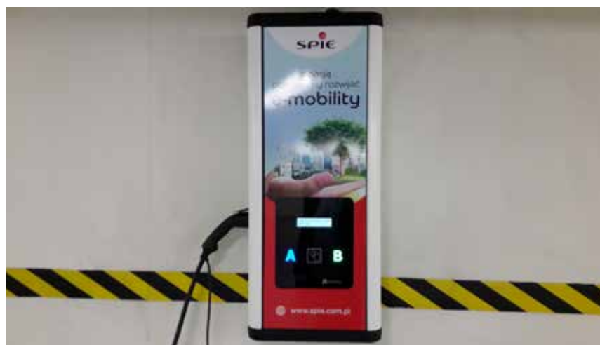
Fot. 2. Stacje ładowania Wallbox 2x22kW w garażu budynku biurowego; fot. SPIE
