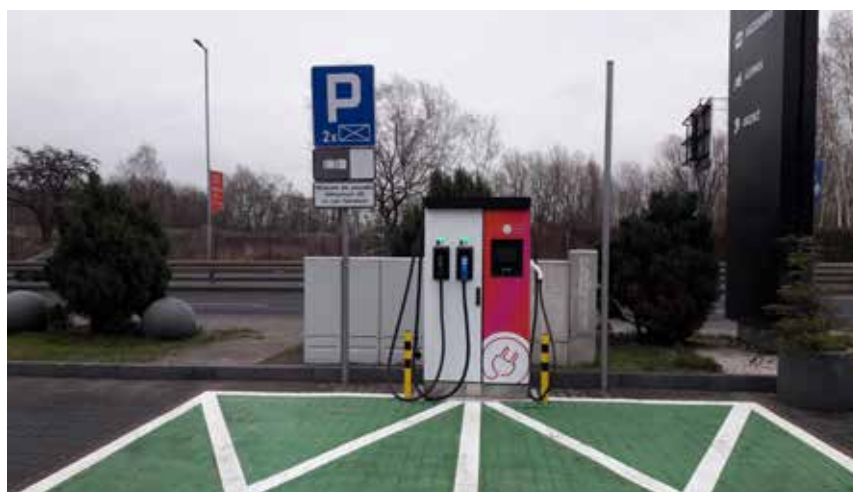
Fot. 4. Stacja ładowania DC 50 kW; fot. SPIE
