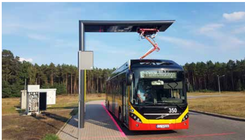
Fot. 5. Stacja ładowania autobusów; fot. SPIE
