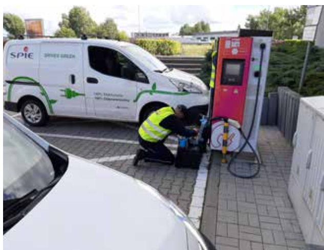
Fot. 7–8. Zespół serwisowy SPIE w czasie przeglądu stacji DC; fot. SPIE
