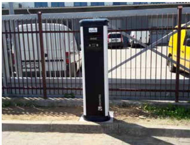
Fot. 3. Wolnostojące stacje ładowania 2x22 kW; fot. SPIE
