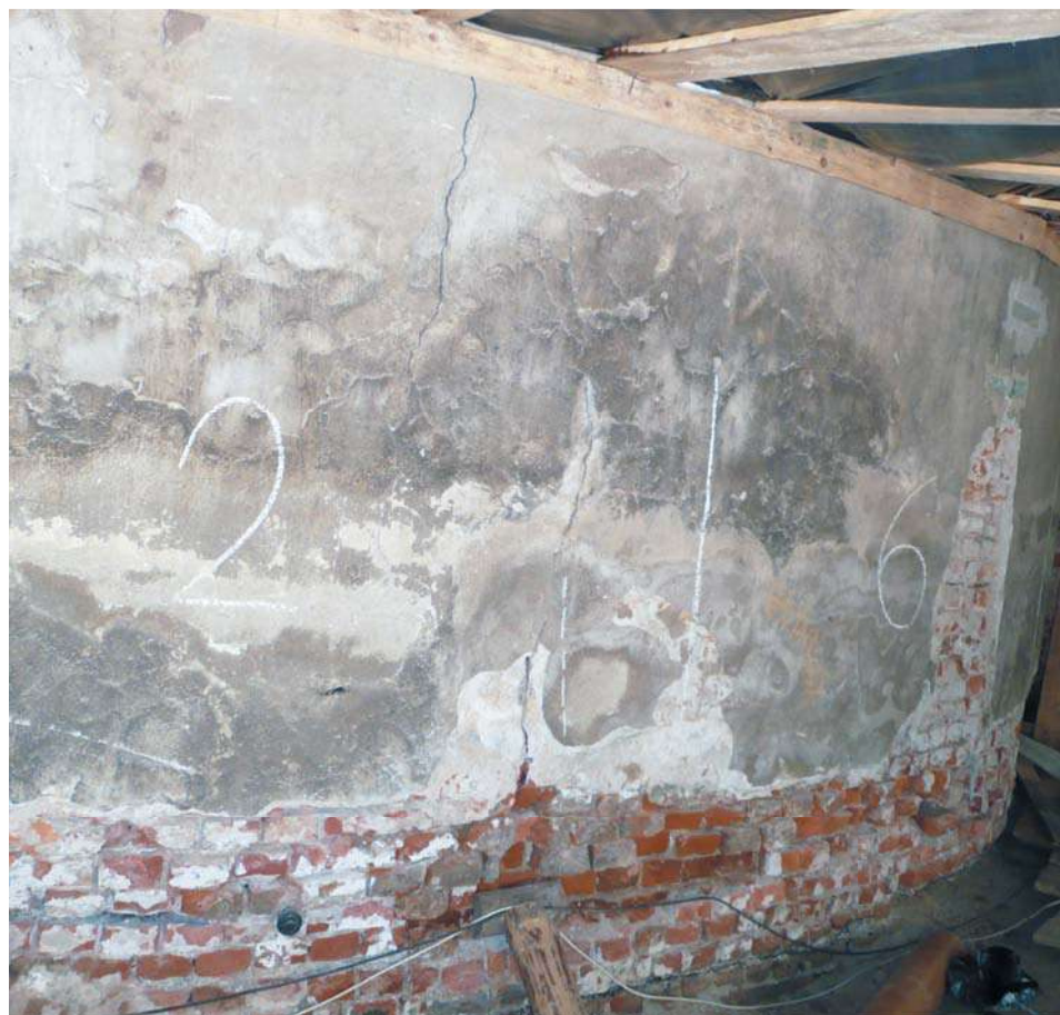
Fot. 3. Kondensacja wilgoci na izolacji wannowej w pomieszczeniu Źródło: Archiwum autora
