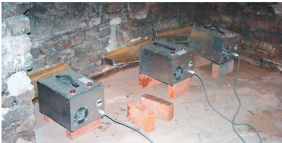
Fot. 8. Suszenie – mikrofalowe przegrody Źródło: C. Magott
