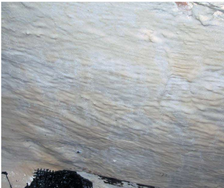
Fot. 4. Objawy zawilgocenia higroskopijnego Źródło: Archiwum autora
